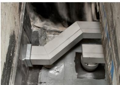
Ein ankonfektioniertes Übergangsstück sichert den Anschluss des Rechteckrohrs des SitaTurbo Gullys an das Rundrohr der Hauptentwässerung.
