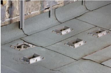
Im ersten Wellental an der zweiten Giebelwand wachen ein Hauptentwässerer und vier Notentwässerungsgullys mit 55 Millimeter hohem Anstaeuelement.
