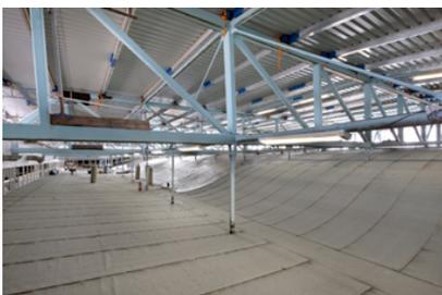
Die Entwässerung des wellenförmig angelegten Dachs des Agrippabades war eine technische Herausforderung.
