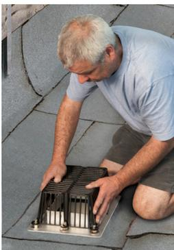
Der Kiesfang komplettiert den Einbau. Er schützt vor dem Eintrag von Laub und hilft so, die hohe Ablaufleistung des SitaTurbo Gullys zu erhalten.
