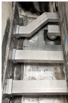
Höchste Entwässerungsleistung auf engstem Raum: drei Rechteckrohre münden in Wasserspeiern, eins führt in die Hauptentwässerungsleitung
