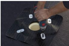
**Sobald die Wunschanschlussmanschette fixiert war,** konnte die abschließende Dachbahn verlegt werden. Alle Montagearbeiten konnten vom Dach aus durchgeführt werden.
