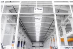
**Parallel zur Hallendecke angeordnet** nehmen die Entwässerungsleitungen kaum Raum in Anspruch. Auf der linken Seite sieht man die parallele Anordnung von Haupt- und Notentwässerungsstrang.
