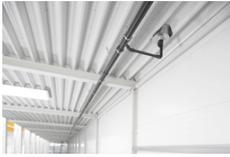
**Der Einzelanschluss einer SitaFiresafe Brandschutzeinheit** mit integriertem DSSProfi Gully speist seine Regenspende in das horizontal angelegte Hauptentwässerungsrohr ein.
