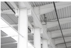
**Platzsparend horizontal zur Deckenkonstruktion** verlaufende Leitungsführungen sind ein großes Plus der Druckströmungsentwässerung.
