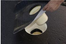
**Nach dem Ausschneiden des Negativprofils** in der Wärmedämmung wurde das Aufstockelement mit der Wunschanschlussmanschette eingesetzt.
