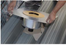
**Der komplett vormontierte SitaFiresafe** - oben mit Verstärkungsblech, unten mit Brandschutzmanschette und Anschlussrohr - konnte direkt in die Durchdringung des Trapezblechdachs eingesetzt werden.
