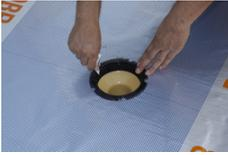
**Der eingesetzte Winkeldichtring erhielt einen Gleitmittelauftrag,** um das Einsetzen des Aufstockelementes zu erleichtern.
