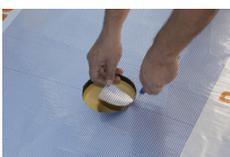
**Die Dampfsperre im Bereich des Gullytopfes** wurde einfach mit dem Cutter ausgeschnitten.
