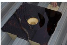
**MIFA Sickenvollfüller aus nicht brennbarem Material** sichern den Bereich der angeschnittenen Sicken. Der bituminöse Anstich des Verstärkungsblechs und des Gullykragens bereitete die Aufbringung der Dampfsperre vor.
