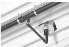
**Festpunktausbildung mit SitaClamp Rohrschellen**, die die Befestigung im Anschlussbereich der Einzelanschlüsse fixieren.
